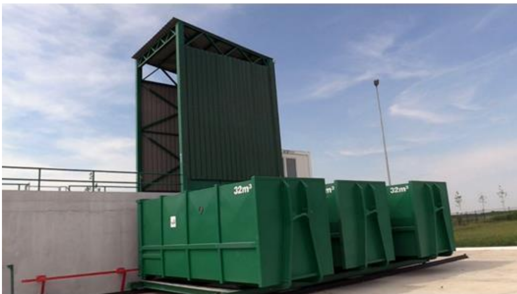
Слика бр. 3: Усипни кош и роло контејнери на трансфер станици
